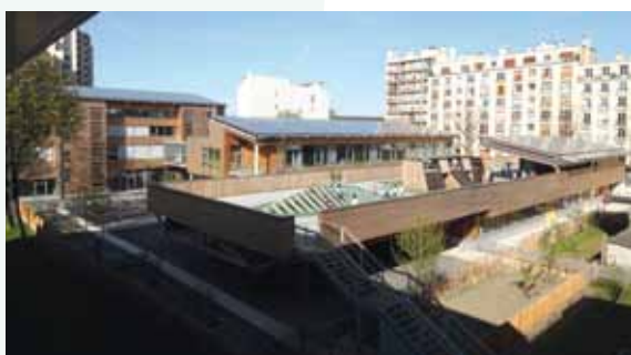
Figure 14 – École zéro énergie à Pantin architecte : Méandre – Photo : Olivier Wogenscky
